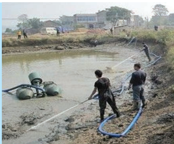
Очистка водоема малым земснарядом
